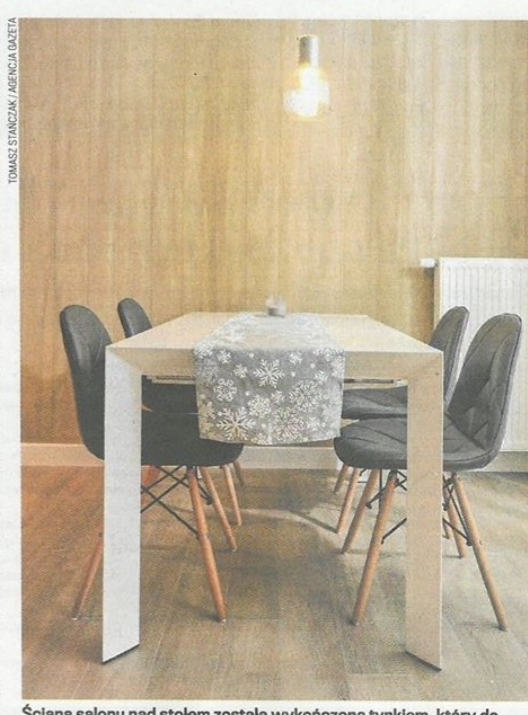
Ściana salonu nad stołem została wykończona tynkiem, który do złudzenia przypomina drewno
